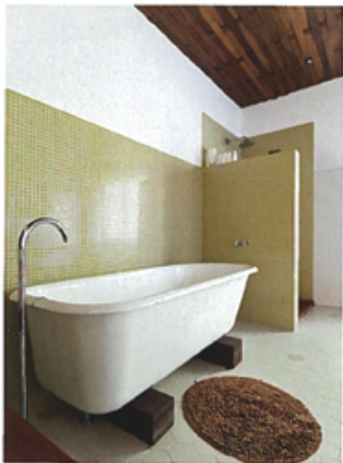
Naapuritalon vanha kylpyamme kunnostettiin ja asennettiin tukevien merbaupölkkyjen päälle.
