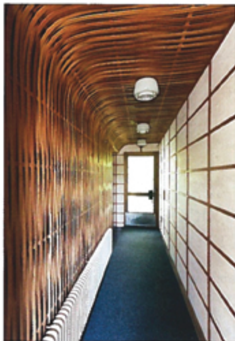
Käytävässä, joka erottaa saunaosaston muista tiloista, on jalopuusäleistä tehty "seinäkatto".
